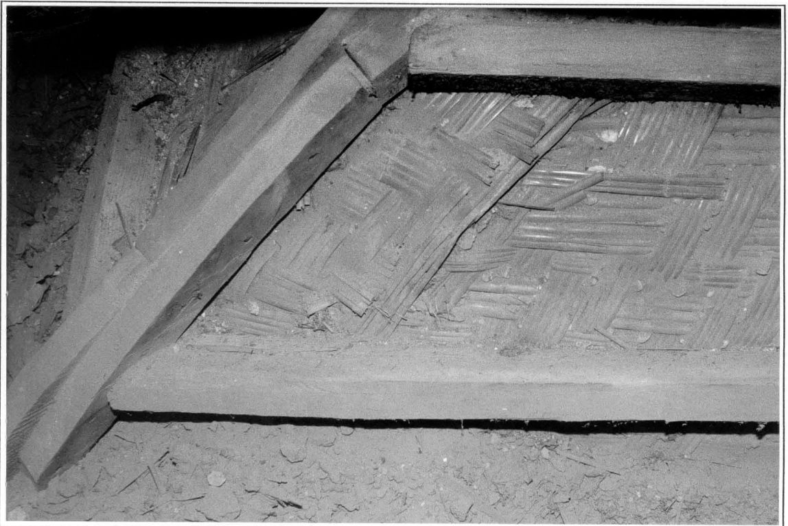
B Die Eckausbildung am Leichtbaugewölbe über dem heutigen Raum 308
